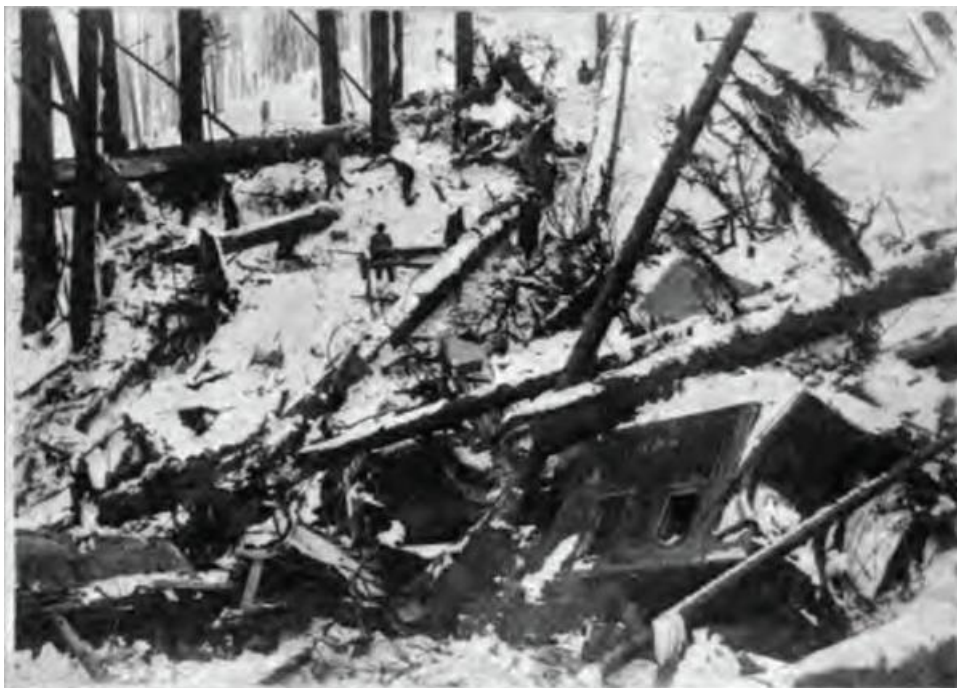
Рис. 19. Здание, разрушенное лавиной.
